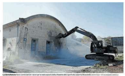
La demolizione. Sono cominciate le opere per la realizzazione della cittadella dello sport alla caserma Boscariello di Miano. A destra: un'immagine aerea del cantiere
