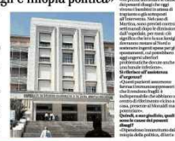
La struttura ospedaliera di Napoli
