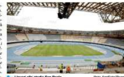
I lavori allo stadio San Paolo
